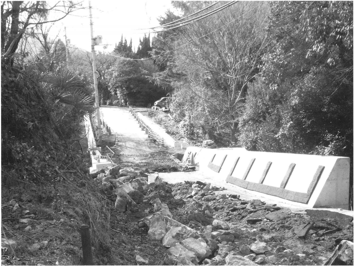
大阪府農免農道 服部川区間(擁壁設置状況北より)
