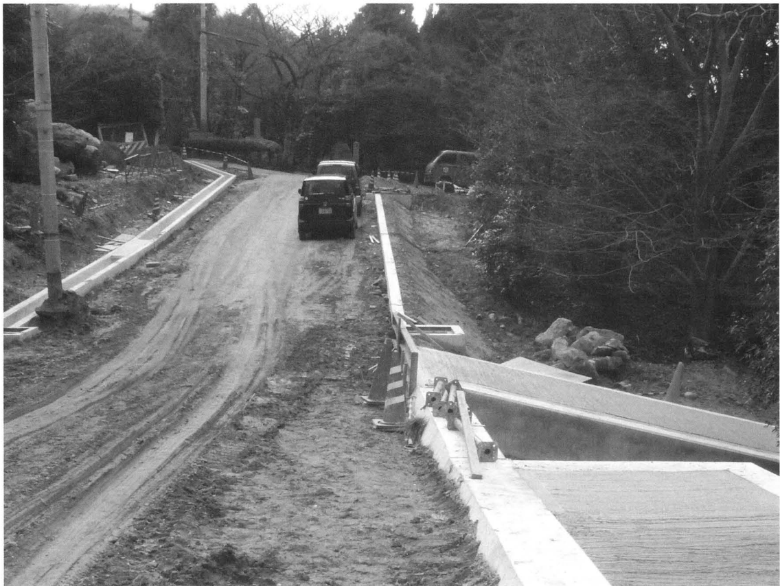
大阪府農免農道 服部川区間(盛土工事状況北より)
